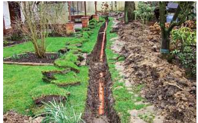
Verlegung der Rohre auf den Gartenparzellen
