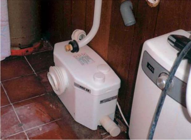
Bild 3 – Aufstellen des Gerätes hinter dem Klo.
