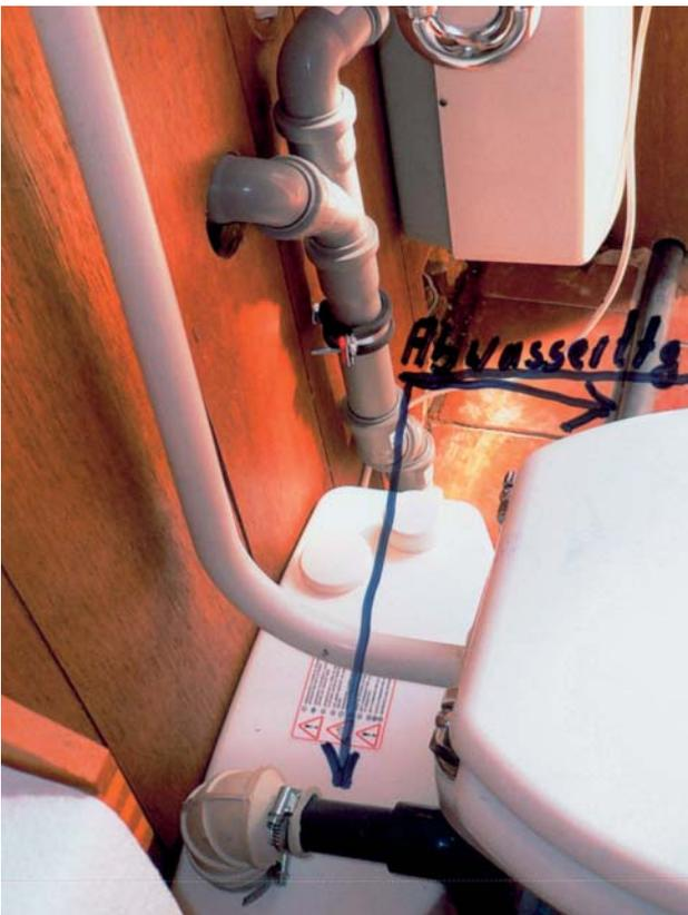
Bild 5 – Montage der Abwasserleitung.
