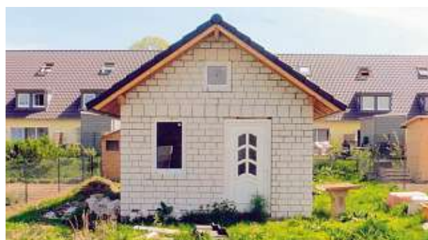
Diese freie Parzelle ist ungepflegt, das Gartenhaus ist bewohnbar, aber noch nicht fertig.
